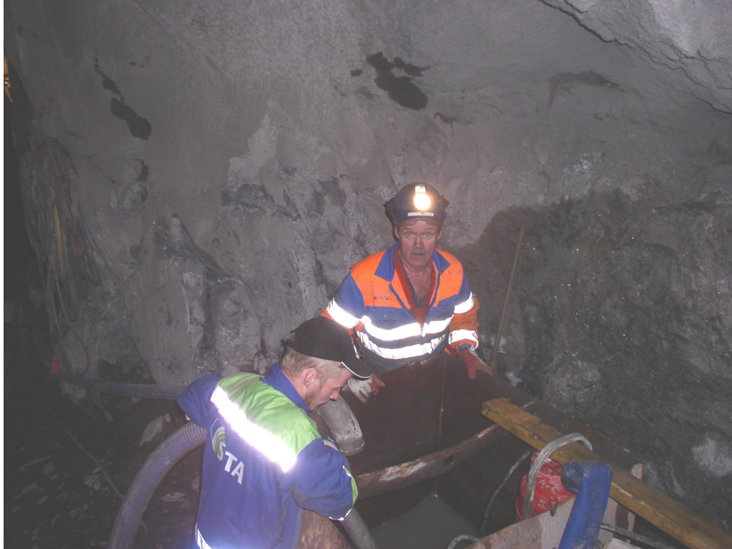
Foto 9.1.5. Slamsugning ur sedimentationskar - Namntall
