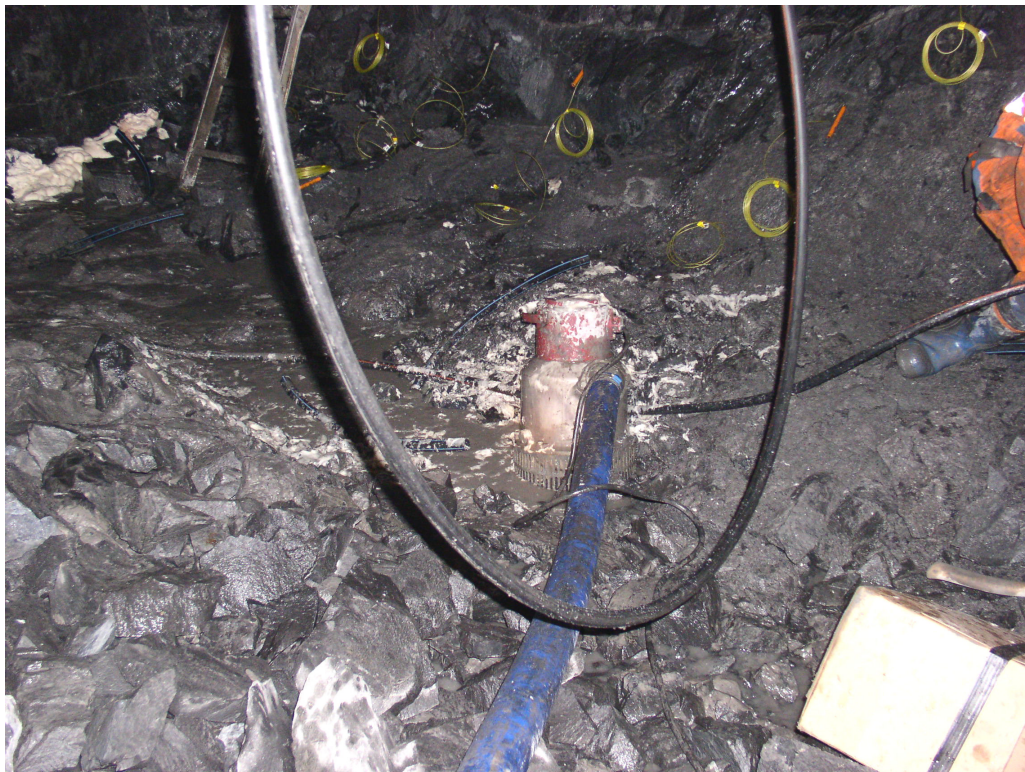
Foto 8.1.6. SSE spill på och nära dränvattenpump – Björnböle
